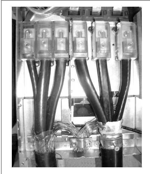
그림6-16. 케이블 설치 N800, FR8
